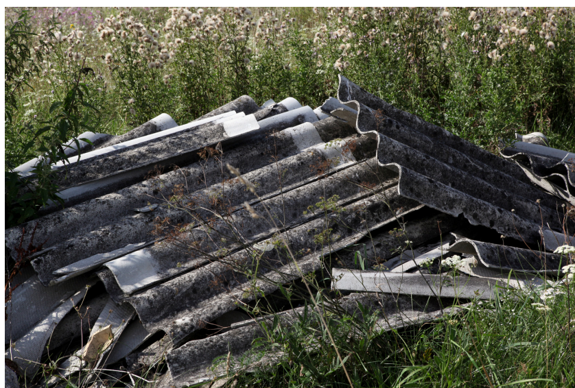
Fot.5. Płyty azbestowe złożone luzem bez żadnego zabezpieczenia, często o naruszonej strukturze stanowią zagrożenie dla mieszkańców i turystów
