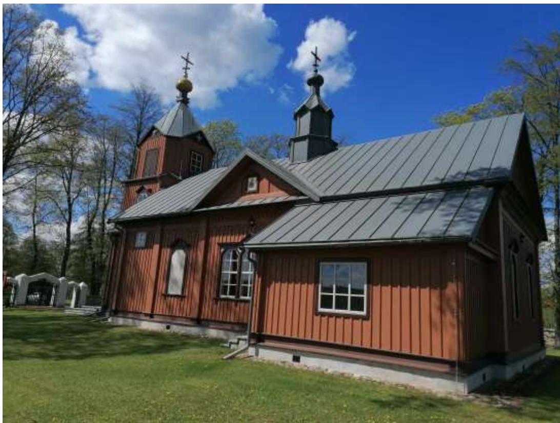
Fot. 3. Elewacja boczna budynku
