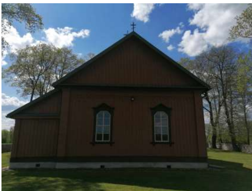
Fot. 2. Elewacja tylna budynku
