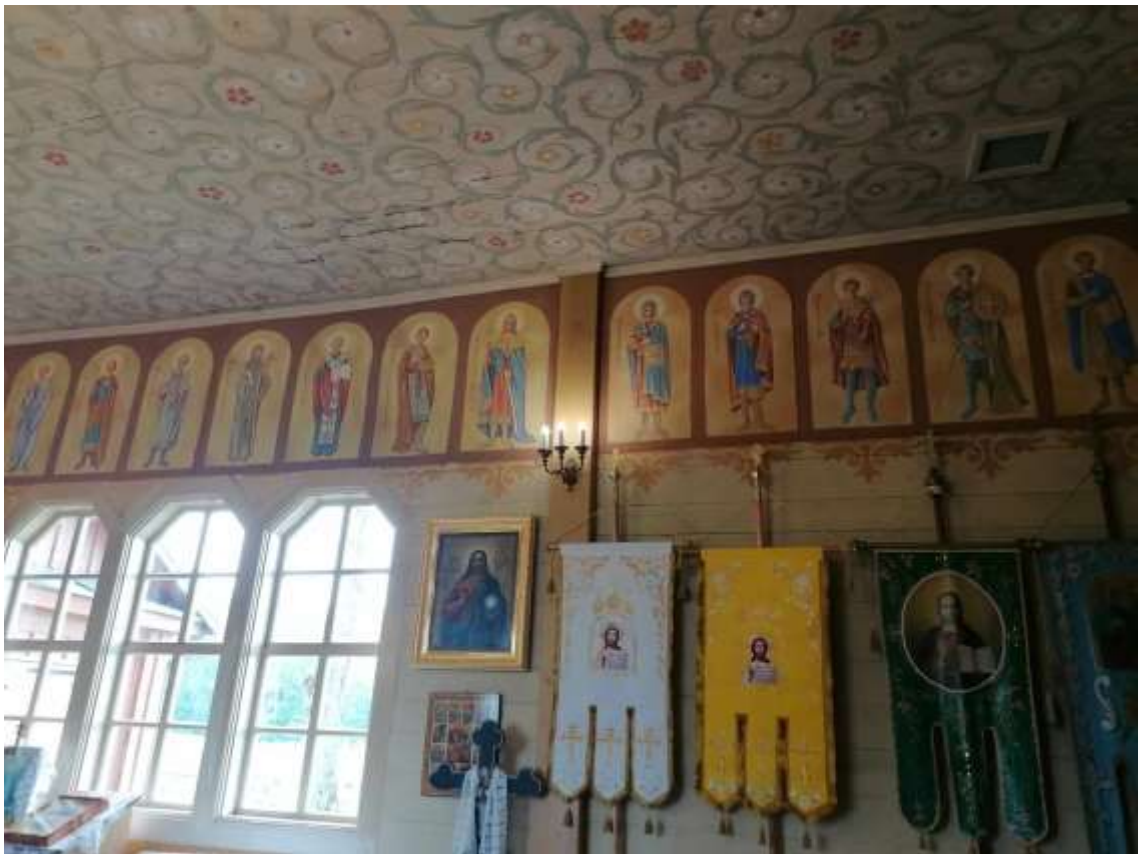
Fot. 9. Wnętrze budynku- nawa główna / widok na istniejącą dekorację ścian (fragment).
