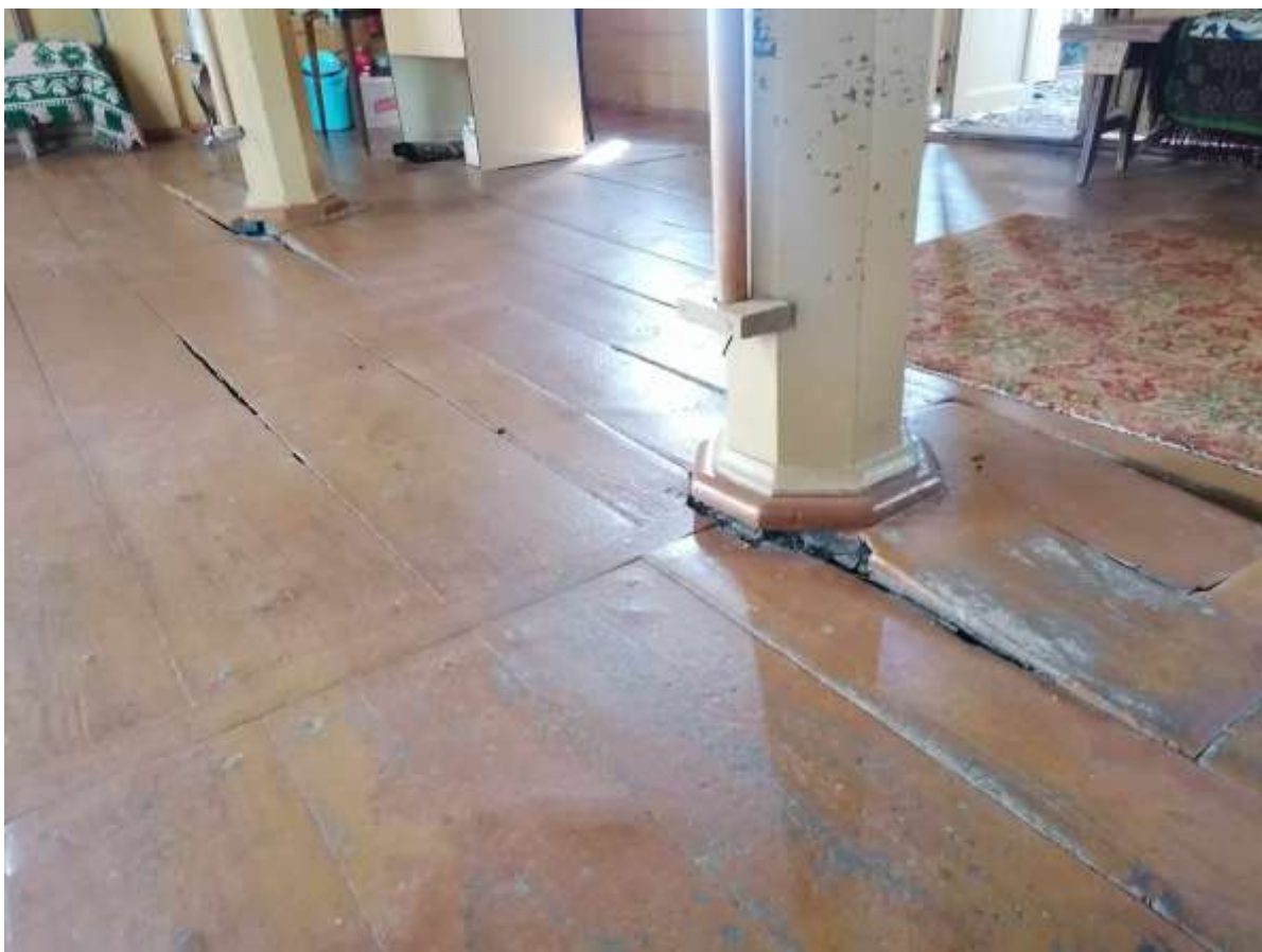
Fot. 8. Wnętrze budynku- nawa główna / widok na podłogę (przeznaczona do remontu).
